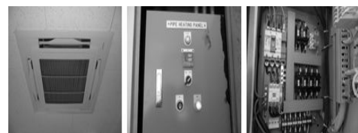
그림 9. Freezing Protection System
